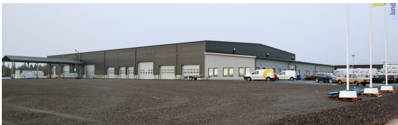
På Haraholmens nya industriområde har den första industrifastigheten färdigställd. Foto: Britta Elfving Persson
